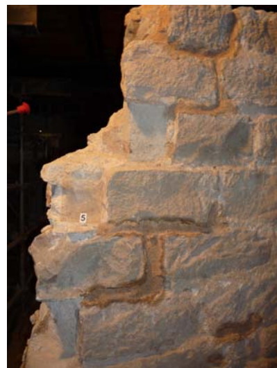
Punt nº 5 : consolidat amb injecció, morter vermellós 1, morter blanc i reforçat per un punt amb totxo i calç hidràulica.
