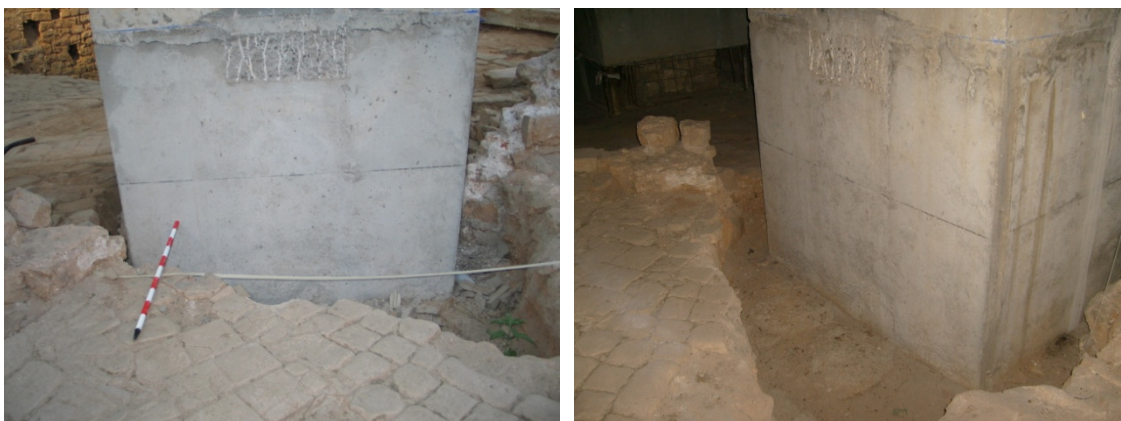
Figs. 22-23 Detall de l'encepat núm.49 abans i després de la intervenció.
