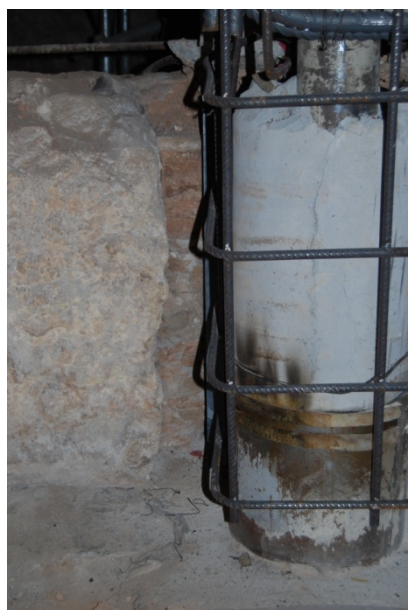
Fig. 49. Detall del mur UE 511 retallat per aplicar-hi la placa d'acer.
