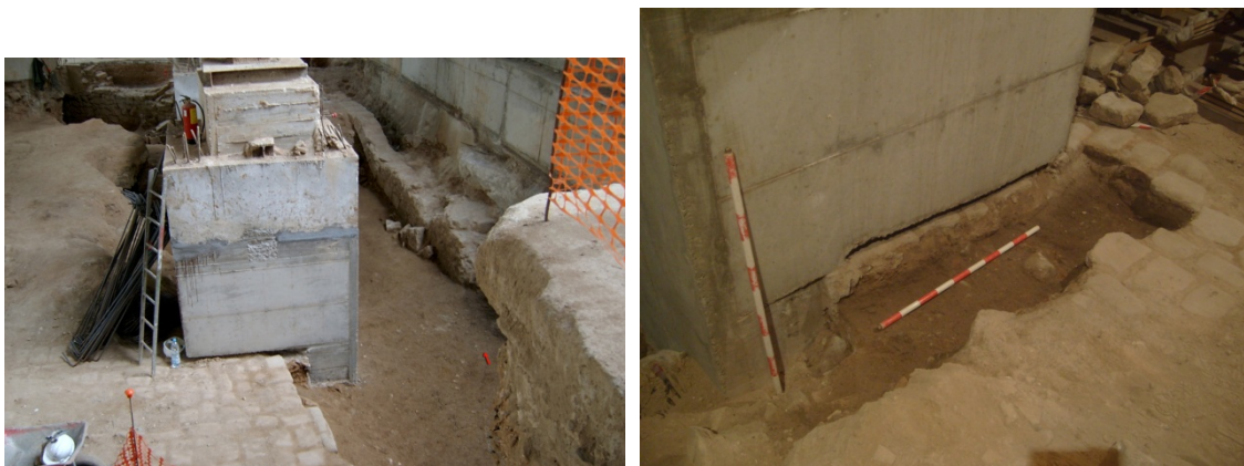
Figs. 5-6 Detall de l'encepat núm.32 abans i després de la intervenció.
