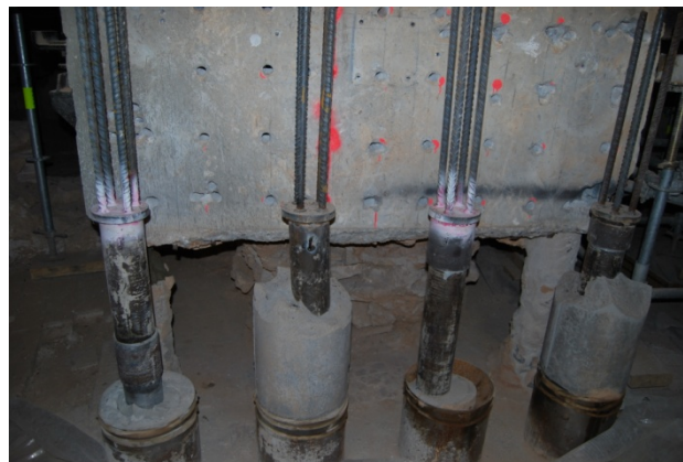
Fig. 46. Detall de l'encepat repicat abans de col·locar-hi l'encofrat i la placa d'acer.
