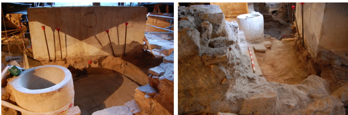
Figs. 86-87 Detall de l'encepat núm.104 abans i després de la intervenció.
