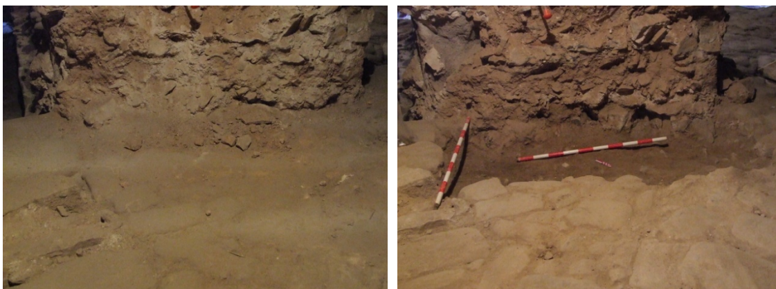
Figs. 100-101 Detall de l'encepat núm.119 abans i després de la intervenció.
