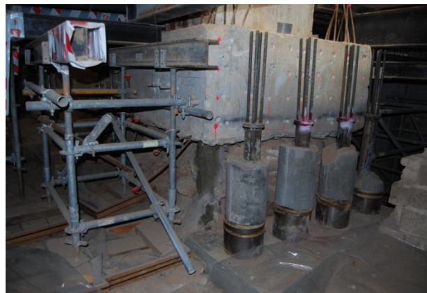
Fig. 55. Detall de l'encepat abans de col·locar-hi l'encofrat i la placa d'acer.
