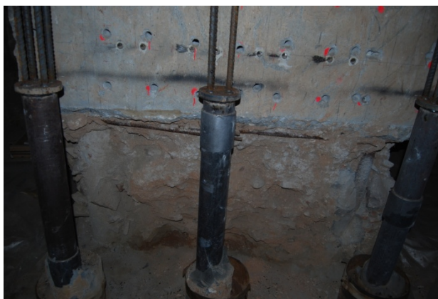
Fig. 110 Detall del procés de construcció del recreixement de l'encepat.
