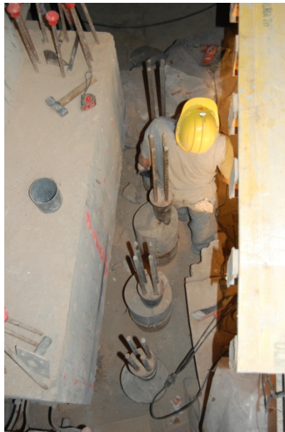
Figs. 43 Detall de l'encepat núm.58 en les feines prèvies a la construcció del recreixement.
