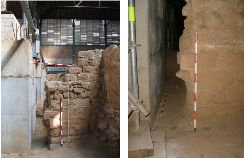
Figs. 14-15 Detall de l'encepat núm.45 abans i després de la intervenció.
