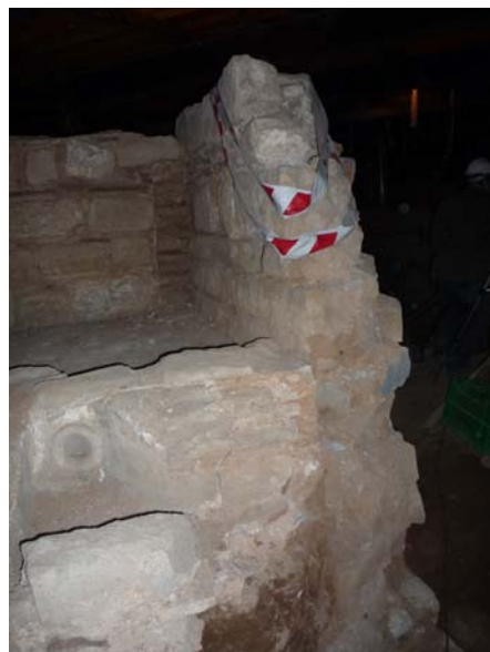
Punt n° 3: Presenta risc d'esfondrament, carreus i morter trencats.
