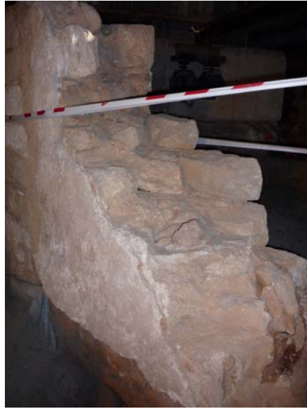
Punt n° 4: Presenta risc d'esfondrament, carreus i morter trencats.
