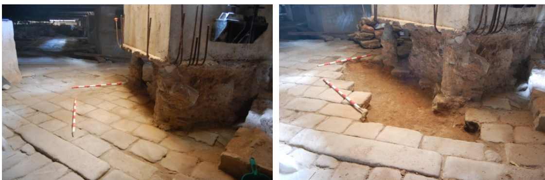
Figs. 71-72 Detall de l'encepat núm.97 abans i després de la intervenció.
