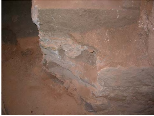
Punt nº1 : consolidat per injecció amb Torraca i amb morter vermellós 1.
