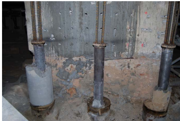
Fig. 107 Detall del procés de construcció del recreixement de l'encepat.
