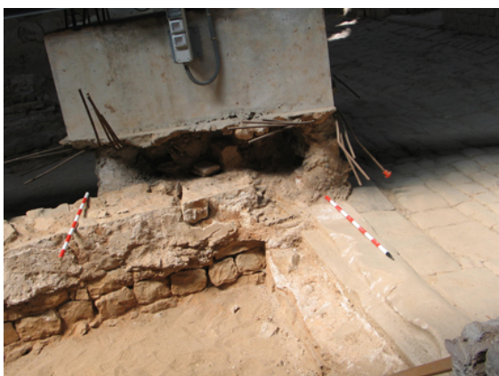
Figs. 56-57 Detall de l'encepat núm.63 abans i després de la intervenció.
