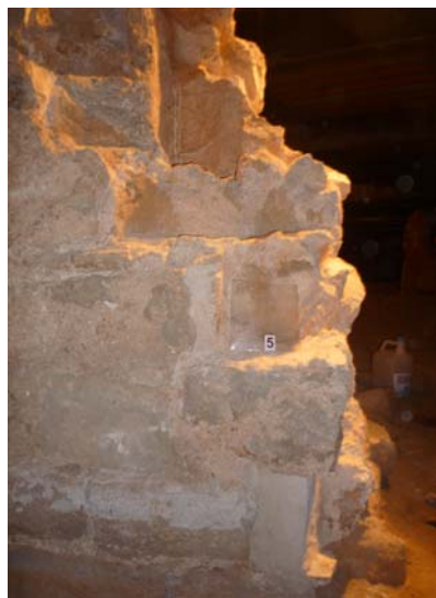
Punt nº 5 : consolidat amb injecció, morter vermellós 1, morter blanc i reforçat per un punt amb totxo i calç hidràulica.
