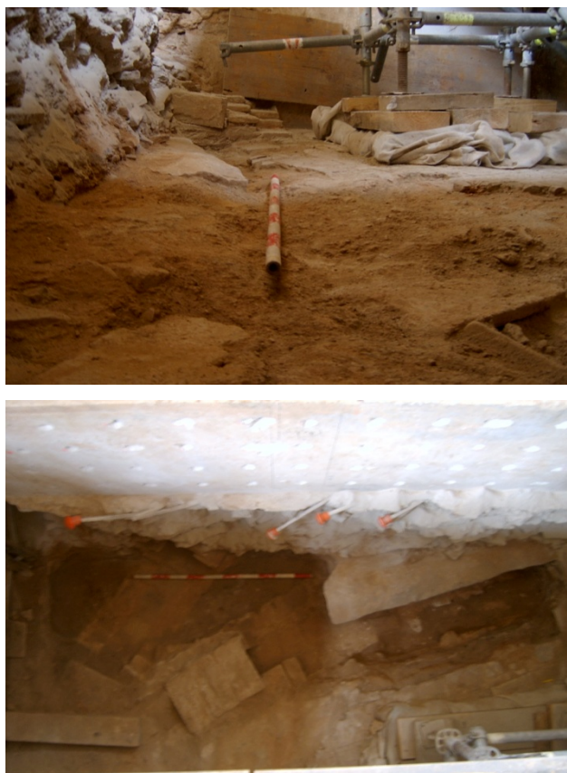
Figs. 33-34 Detall de l'encepat núm.55 abans i després de la intervenció.
