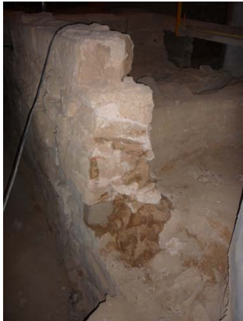
Punt nº 2 : consolidat amb injecció, morter vermellós1 i dau de reforç.
