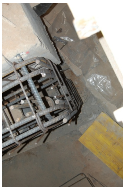
Figs. 58 Detall de la cunya realitzada en el paviment del carrer.
