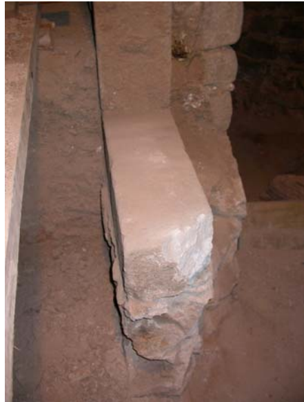
Punt nº 1: presenta brutícia superficial i trencament del morter.
