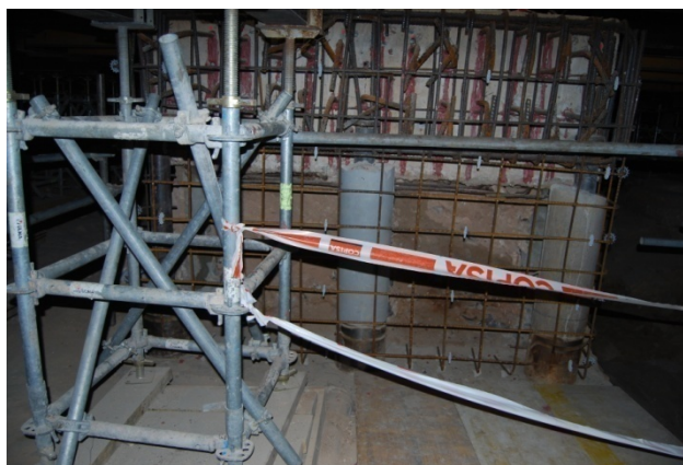
Fig. 29. Detall de l'estructura per a realitzar l'encofrat.
