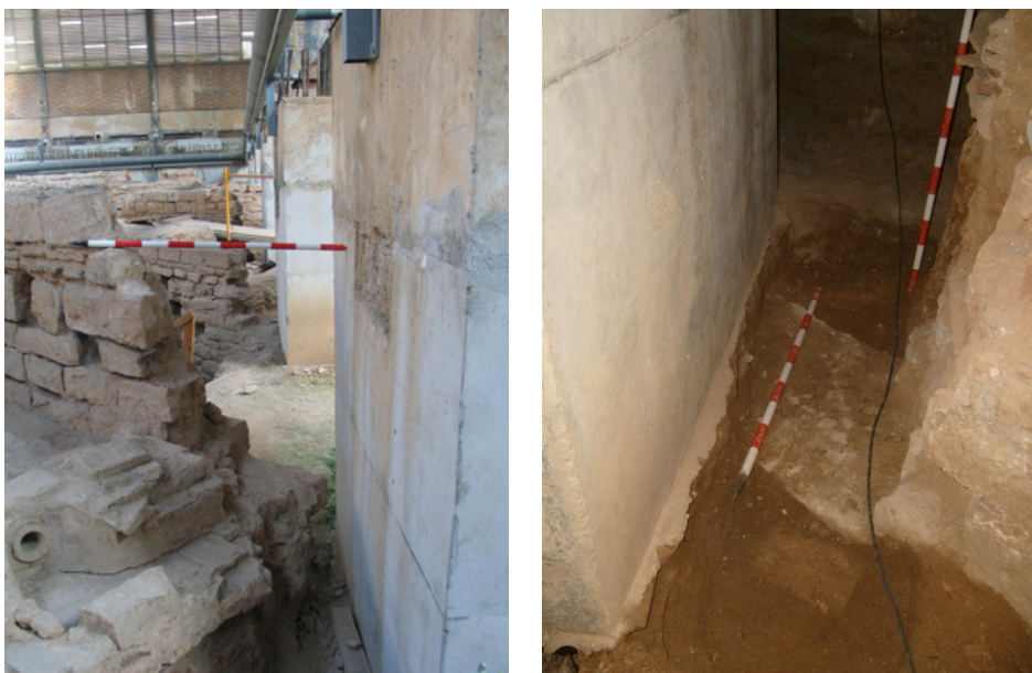
Figs. 63-64 Detall de l'encepat núm.93 abans i després de la intervenció.
