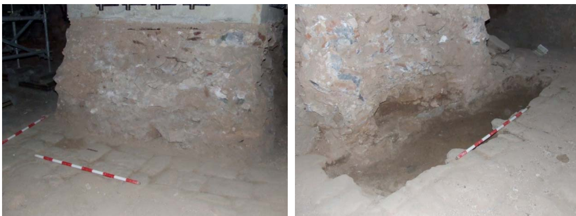
Figs. 103-104 Detall de l'encepat núm.120 abans i després de la intervenció.
