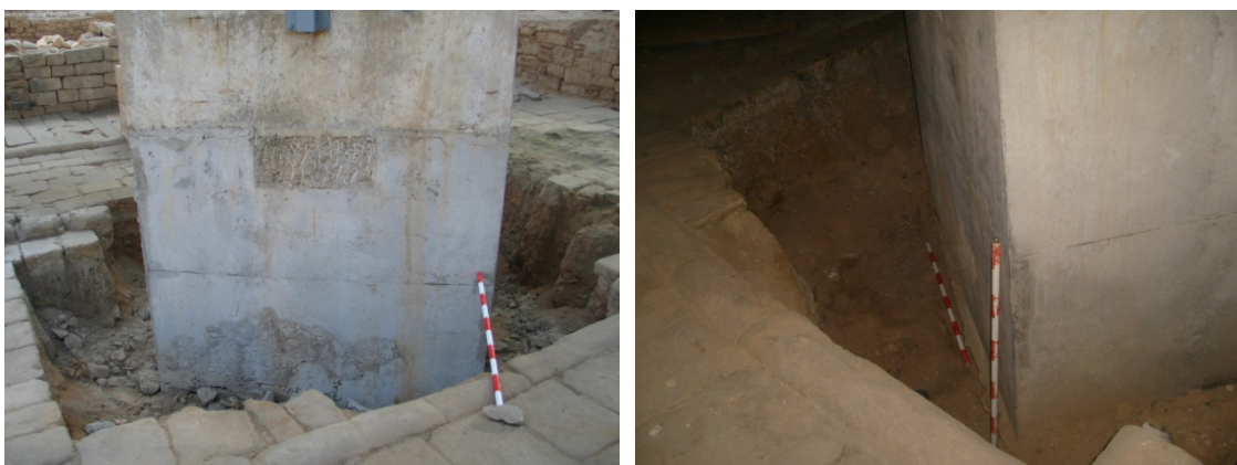
Figs. 69-70 Detall de l'encepat núm.96 abans i després de la intervenció.
