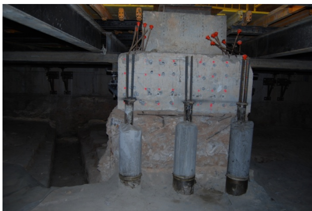
Fig. 102 Detall del procés de construcció del recreixement de l'encepat.
