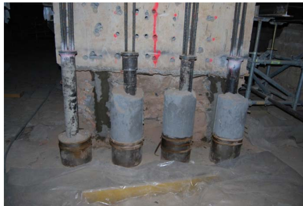
Fig. 40. Detall de l'encepat repicat abans de col·locar-hi l'encofrat i la placa d'acer.
