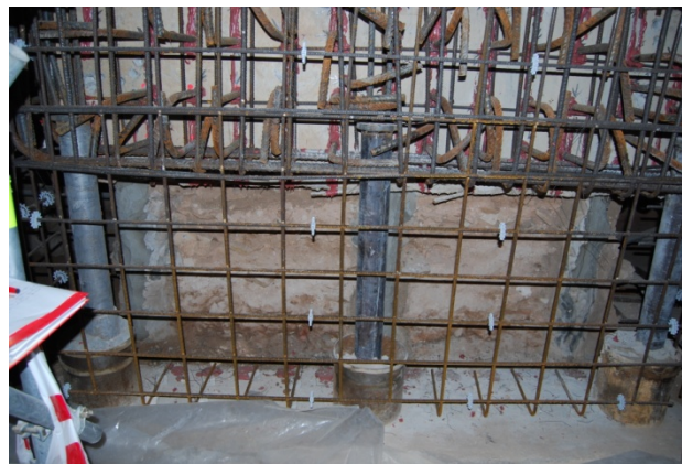
Fig. 26. Detall de l'estructura per a realitzar l'encofrat.
