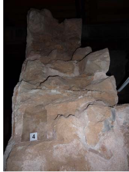
Punt n° 4: Presenta risc d'esfondrament, carreus i morter trencats.
