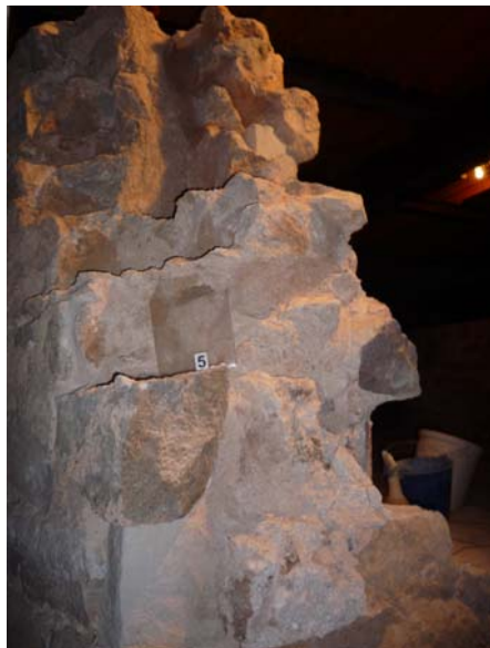
Punt n° 5: s'aprecien morter trencat i pedres que han quedat en voladís.
