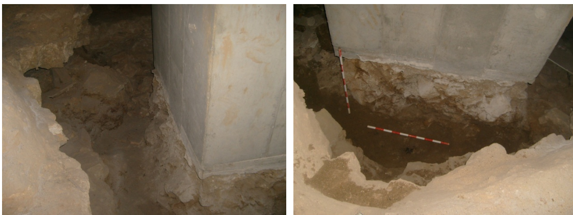
Figs. 3-4 Detall de l'encepat núm.31 abans i després de la intervenció.
