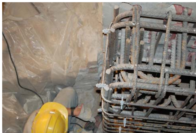
Fig. 32 Detall de l'afectació del mur UE 70272
