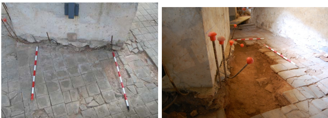
Figs. 90-91 Detall de l'encepat núm.106 abans i després de la intervenció.
