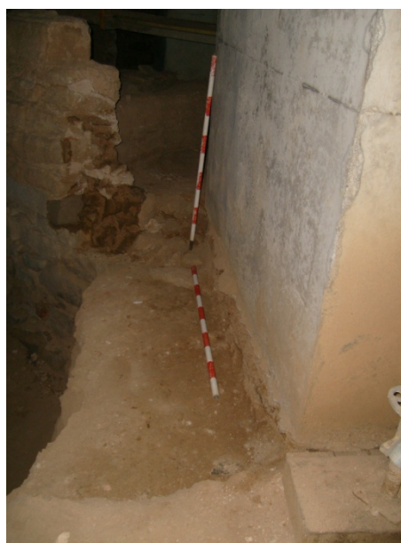
Figs. 61-62 Detall de l'encepat núm.92 abans i després de la intervenció.
