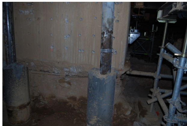
Fig. 79 Detall del procés de construcció del recreixement de l'encepat.
