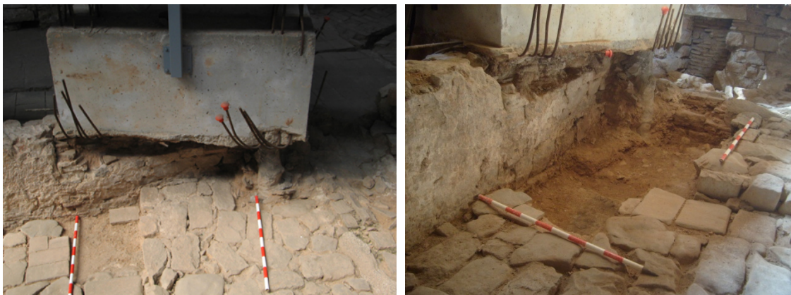
Figs. 47-48 Detall de l'encepat núm.60 abans i després de la intervenció.
