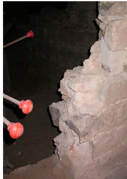
Punt n° 5: s'aprecien morter trencat i pedres que han quedat en voladís.
