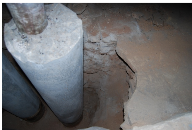
Figs. 52 Detall del paviment retallat UE 5360.
