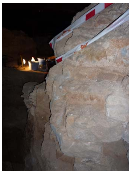
Punt n° 3: Presenta risc d'esfondrament, carreus i morter trencats.
