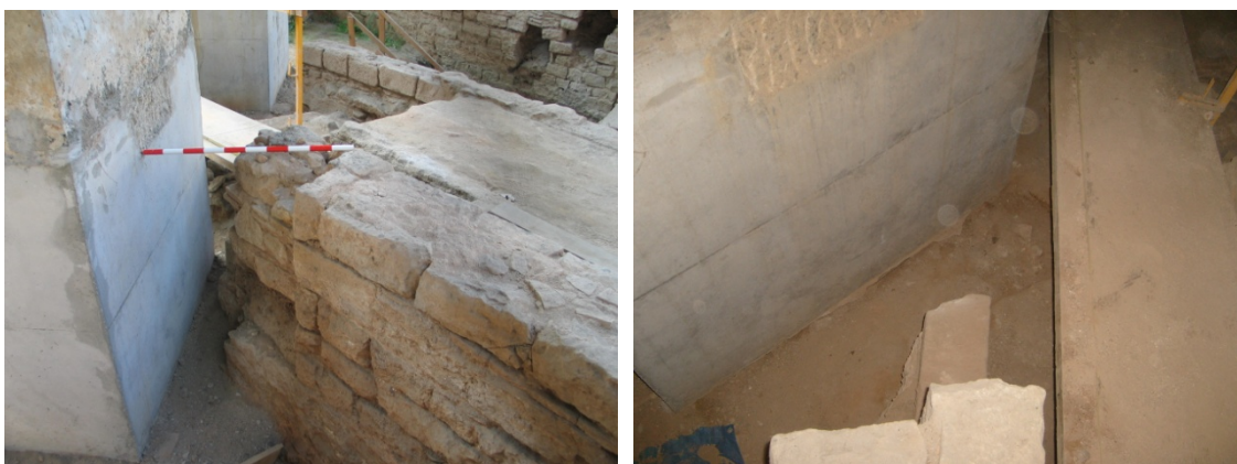
Figs. 59-60 Detall de l'encepat núm.91 abans i després de la intervenció.
