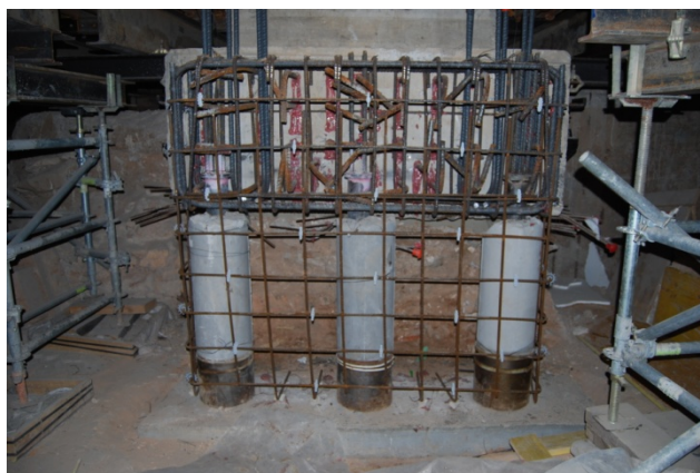
Fig. 9. Detall de l'estructura per a realitzar l'encofrat.
