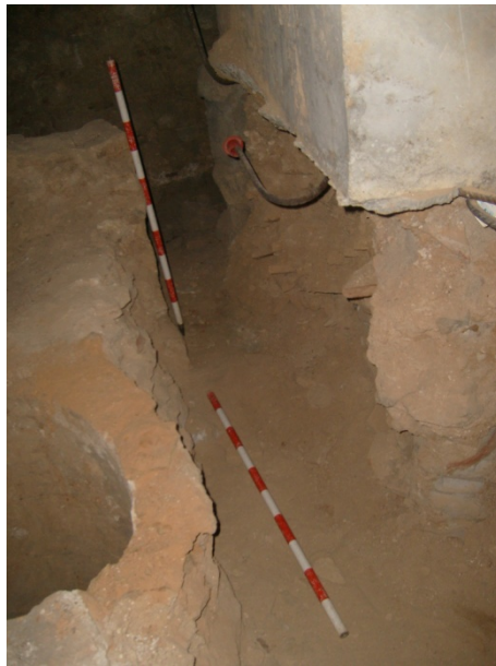
Fig. 35 Detall de l'encepat núm.56 després de la primera intervenció.
