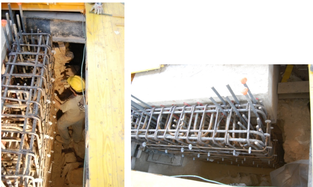
Figs. 12-13. Procés de construcció del recreixement de l'encepat.
