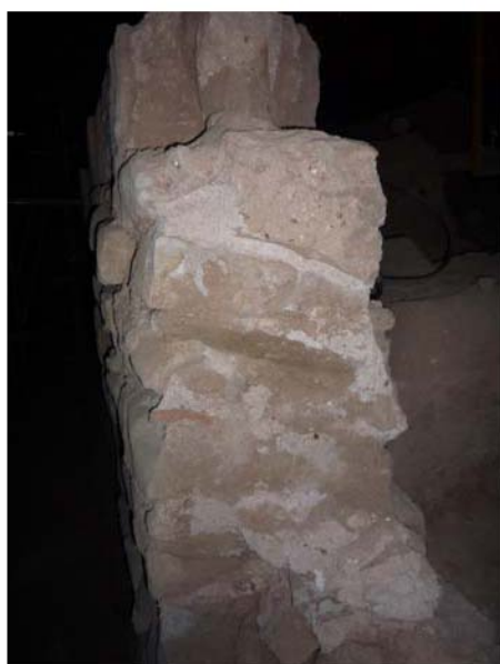
Punt n° 2: S'observa pèrdua de morter i risc d'enderroc sobretot a la part inferior.
